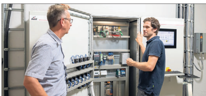
Eine Regulationsanlage zur Energieverteilung – für die Entwicklung und Bedienung sind Fachleute gefragt.
